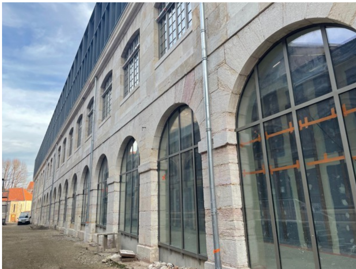
Le bâtiment N fait l'objet d'une restructuration complète sur le site de l'Arsenal, à Besançon. Il rouvrira à la rentrée de septembre..
